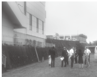
▲旭台会館駐車場の調査
