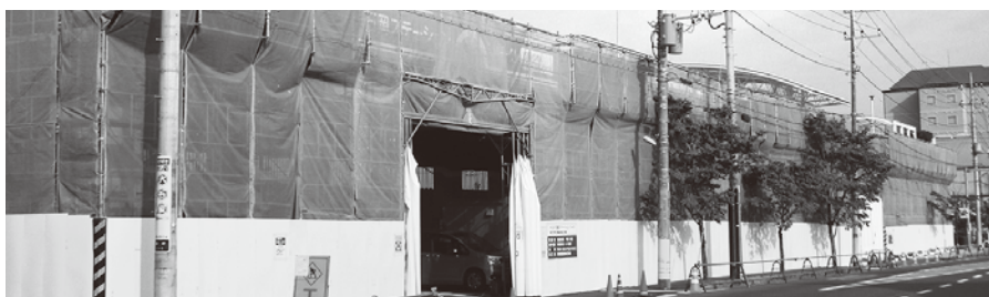
▲工事の進むステーションパーク
