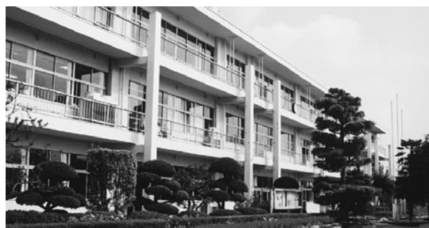
▲昭和49年に建設された北小学校校舎
