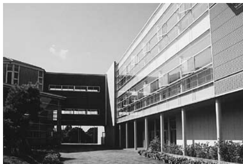
▲市内で最も新しい府中中学校。当然、耐震性に問題はない。
