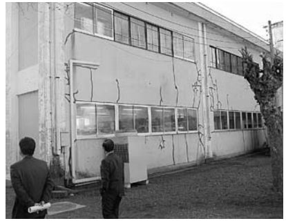
▲ 柿岡中のクラック補修
