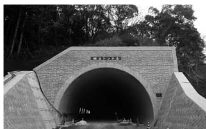
▲朝日トンネル
