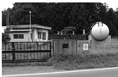
▲地下水を水源とする機場施設
