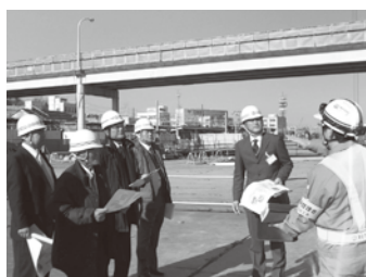
▲駅舎の工事進捗状況を確認
