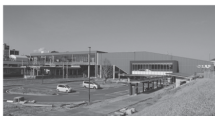
▲工事の進む BRT 専用駅前広場
