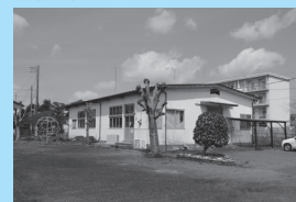
▲令和5年度に建物の解体を予定
