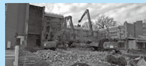
▲旧市民会館解体工事の様子 (令和6年1月23日撮影)
